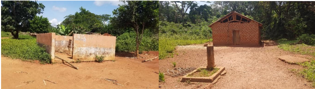
Photos 11 : Forage en panne et mini AEP abandonné d'Alouma
