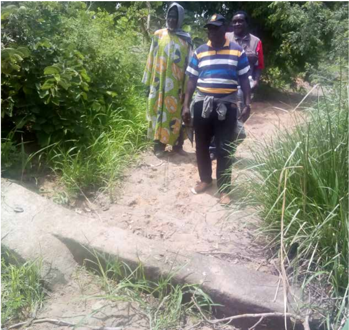
Bief à réhabiliter dans le cadre des APS_Sabongari
