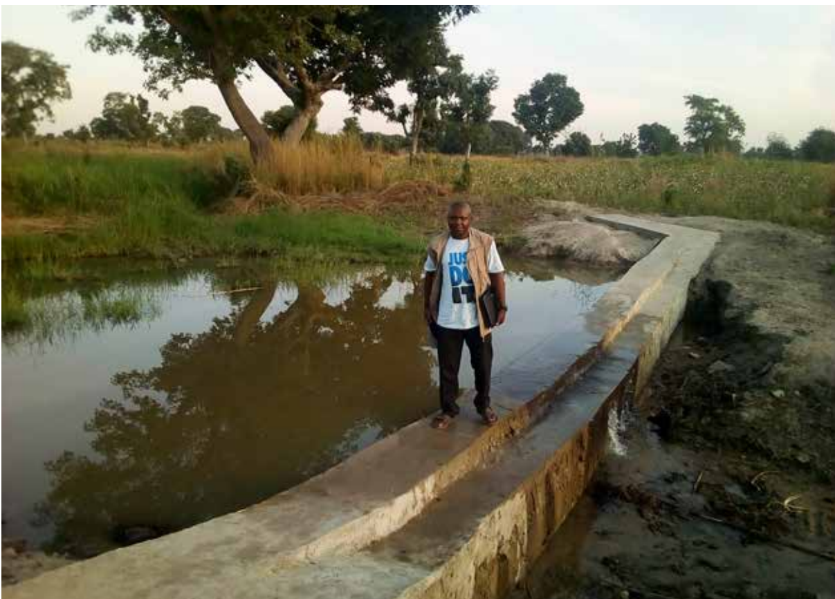
Construction de biefs + marres d'eau
