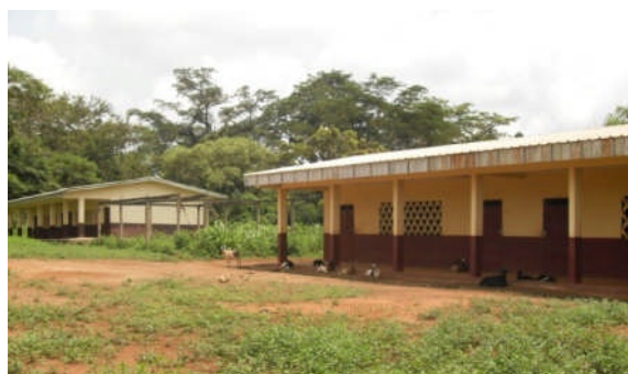
PHOTO 25: Vue des salles de classe de l'EP de Mbouyé
