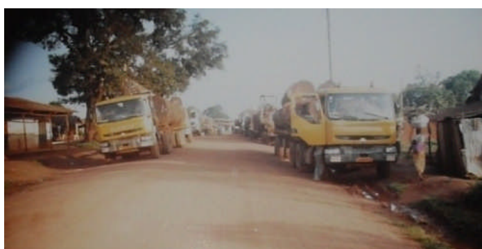
Photo 34 : Vue de la route nationale N° 10 à Kentzou
