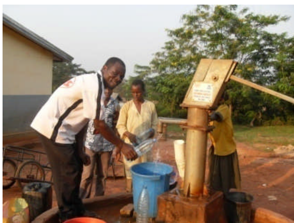
PHOTOS 30 : Vue du forage du CMA de Kentzou
