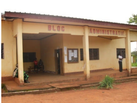
PHOTO 27 : Vue du Bloc Administratif du Lycée de Kentzou
