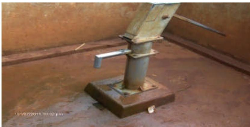
*Photo n°5 : Puits équipé d'une pompe à motricité humaine à Mboma*
