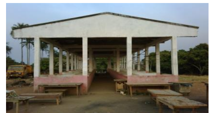
Hangar du marché de Yoko
