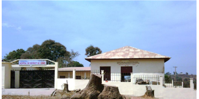
Vue de l'entrée principale de l'HD de Yoko
